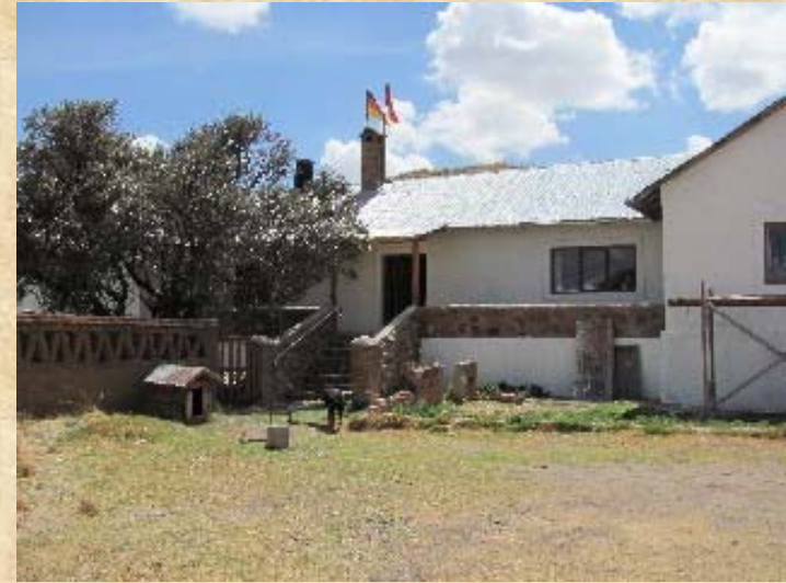
33_Verputzen der Frontseite unseres Hauses_mit Geld aus Ersparnissen
