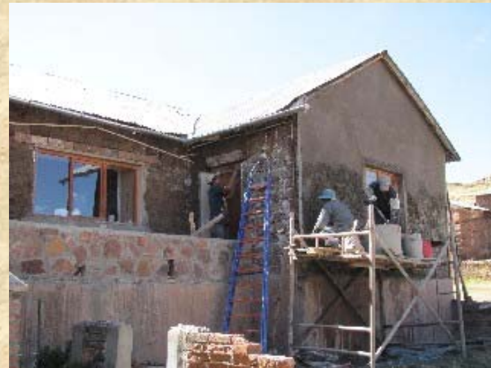
15_Die Frontseite von unserem Haus wird verputzt
